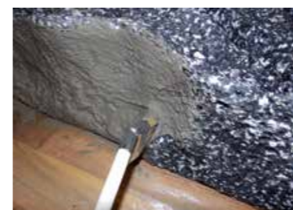
Mit dem Pinsel wird die Masse einfach deckend aufgetragen
