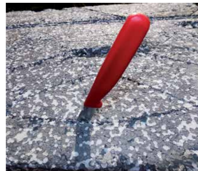
Mit einem Messer werden Kanäle in die Fassadendämmplatte geschnitten
