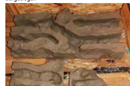
Rückwand und Seitenwände mit erster Fliesenkleber-Beschichtung
