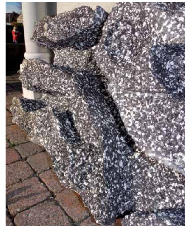
Detailblick auf die fertig bearbeitete Rückwand vor dem Aufbringen von Fliesenkleber
