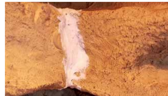
Spalten zwischen den Elementen können z. B. mit streichbarem Füllspachtel geschlossen werden
