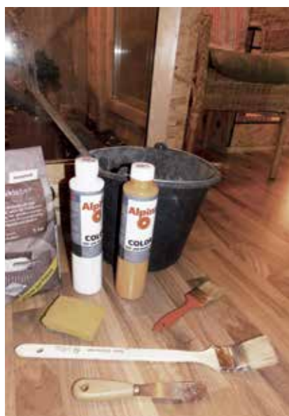
Der nächste Bauabschnitt: Materialien zur Gestaltung der modellierten Wände: Fliesenkleber, Eimer, Pinsel, Spachtel, Abtönfarben, Schwamm
